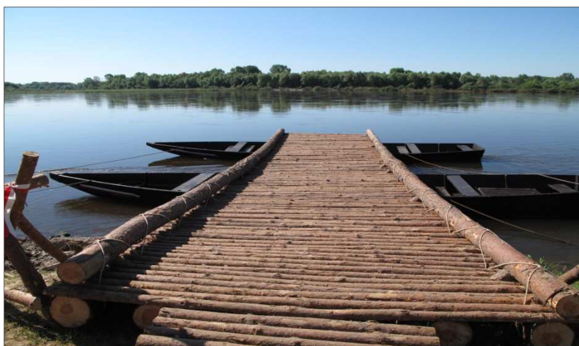
Rys. 5. Replika Mostu Jagiełły, odbojnice na krawędziach pomostu (fot. B. Rymsza)
