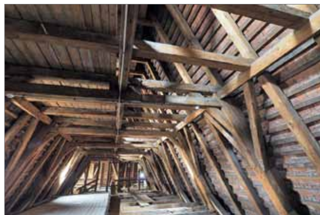
Fragment konstrukcji o stolcach leżących
