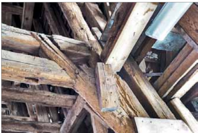
Uszkodzony węzeł konstrukcji
