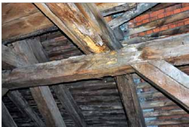
Uszkodzona jętka wzmocniona nakładkami
