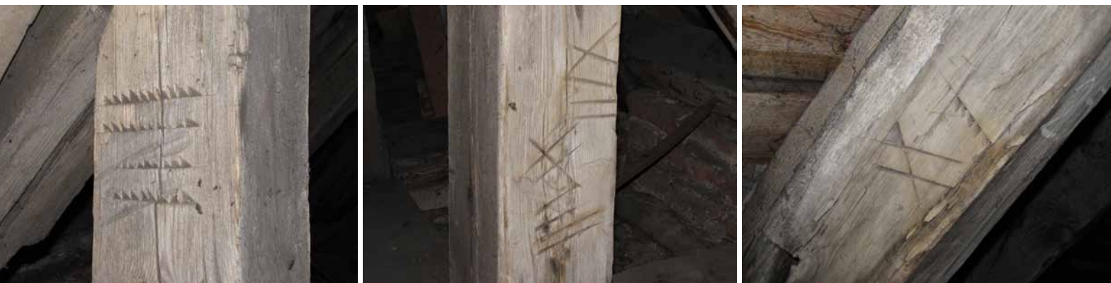
Ciesielskie znaki montażowe XV-wiecznej więźby dachowej nad korpusem nawowym fary św. Jakuba.
