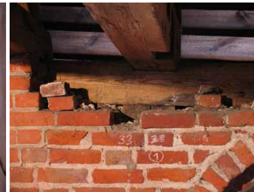
Słup i oczep szkieletowej ściany dziedzicznej południowego skrzydła zamku, obmurowanej już w późnym średniowieczu.
