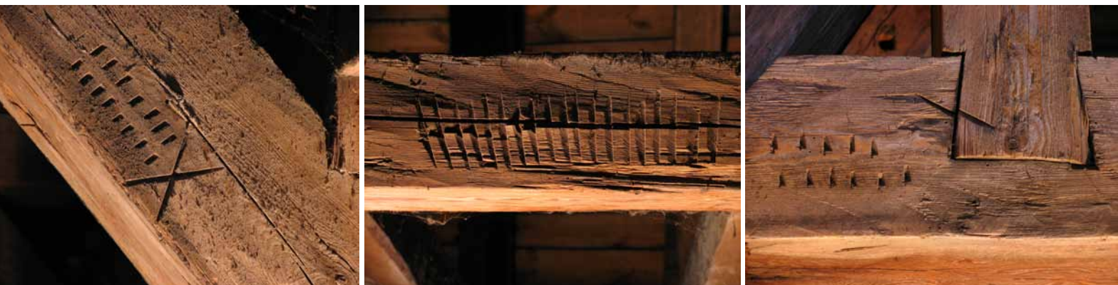
Ciesielskie znaki montażowe więźby dachowej północnego skrzydła zamku.
