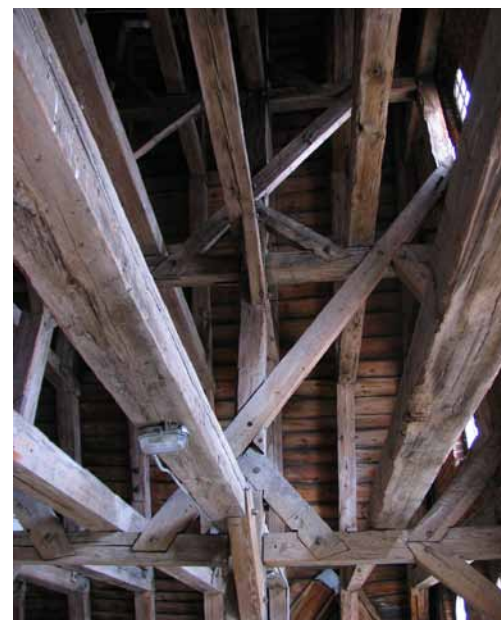
Usztywnienie podłużne wieżby dachowej północnego skrzydła zamku.
