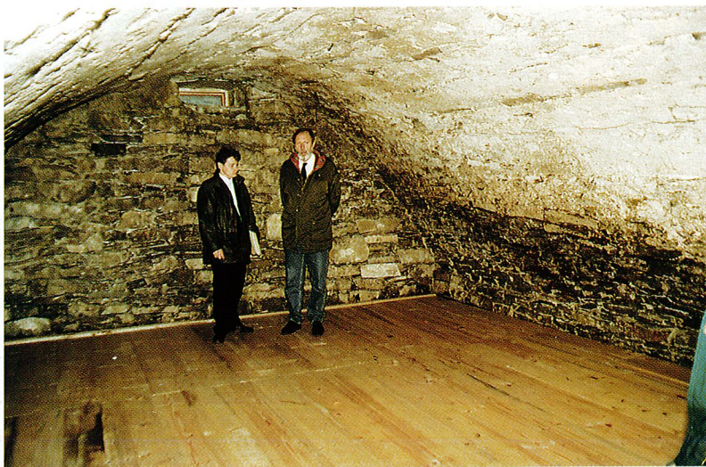
W piwnicy wschodniej dobrze zachowane sklepienie i ściany można było pozostawić bez interwencji konserwatorskiej; pod zrekonstruowaną na wzór pierwotnej podłogą wykonano drenaż z perforowanych rur plastikowych. Na zdjęciu piwnica po konserwacji.
