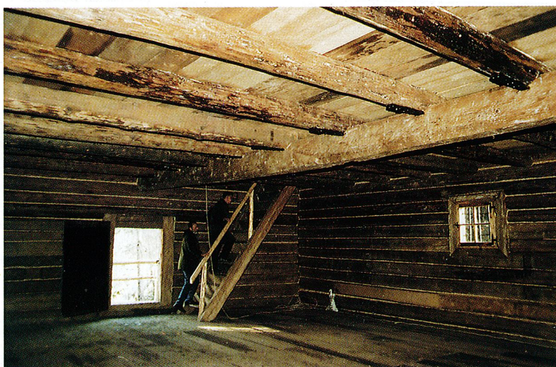
To samo wnętrze przyziemia po pracach konserwatorskich. Końcówki stalowych elementów wzmacniających przy sosenie są mało zauważalne (celowo nie maskowano ich drewnem), a formę nowych skrzydeł okiennych dostosowano do charakteru spichlerza.
