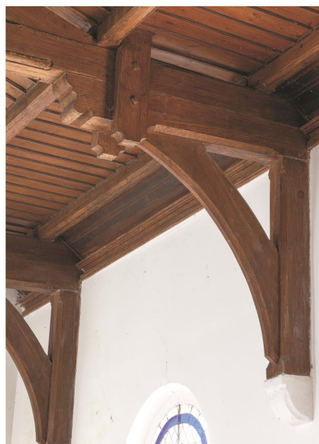
Ryc. 14. Dekoracja malarska oraz opracowanie naroży elementów więźarów i detalu. /fot. autor/
