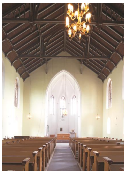
Ryc. 9. Więźba częściowo otwarta z pułapem dwuspadowym nadwieszeniem skośnym. /fot. autor/
