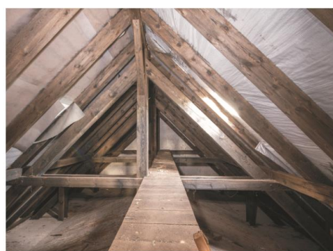
Ryc. 16. Konstrukcja więźby – widok ze strychu. /fot. autor/
