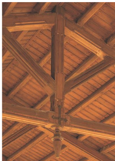
Ryc. 2. Dekoracja malarska oraz opracowanie naroży elementów więźarów i detalu. /fot. autor/
