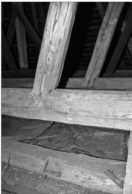
Il. 4. Sieroty, kościół parafialny pw. Wszystkich Świętych. Więźba dachowa nad prezbiterium. IV od zachodu wiąz, strona południowa w widoku od zachodu. Dołem widoczna oryginalna belka wiązarowa z 1427 r. (ze znakiem montażowym), górą wtórna belka z czasu podwyższenia więźby w 1544 r., połączona z oryginalnym mieczem stropowym. Fot. A. Konieczny 2008
