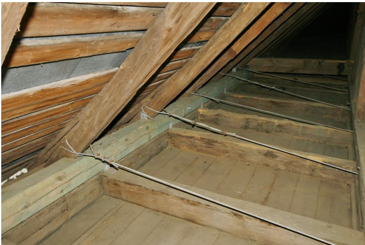
fot.2. Sposób opasania krokwi za pomocą lin stalowych.
