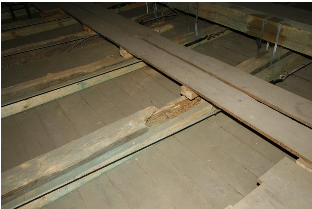
fot.1 Uszkodzone belki wiązarowe (stropowe).
