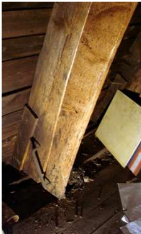
71. Bukowiec, Dom Ogrodnika, więźba, strona wschodnia, dolny fragment krążyny i przypustnicy, (fot. J. Modzelewska, 2008).
