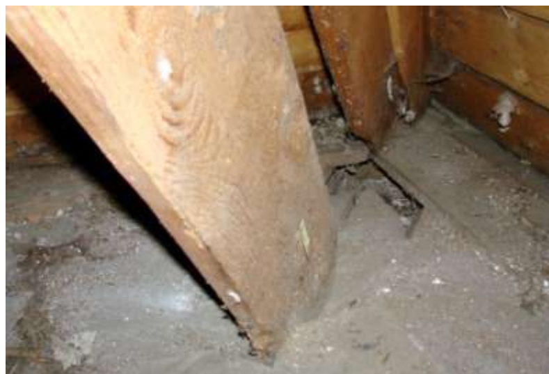
74. Bukowiec, Dom Ogrodnika, więźba, narożnik pd.-zach, detal pokazujący połączenie krążyny narożnej z belką kulawkową (fot. J. Modzelewska, 2008).
