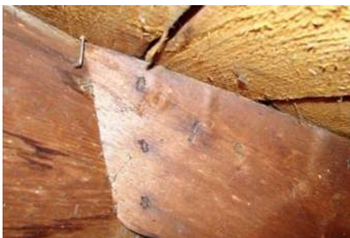
65. Bukowiec, Dom Ogrodnika, więźba, II kondygnacja, narożnik południowo-wschodni, detal pokazujący połączenie krążyny kulawkowej z krążyną narożną (fot. J. Modzelewska, 2007).
