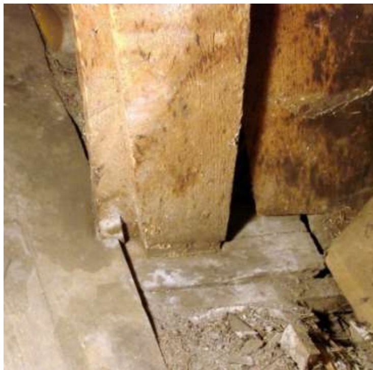
73. Bukowiec, Dom Ogrodnika, więźba, strona wschodnia, detal pokazujący zaczopowanie krążyny w belce wiązarowej; widok od strony południowej – rewers il. 72, (fot. J. Modzelewska, 2008).
