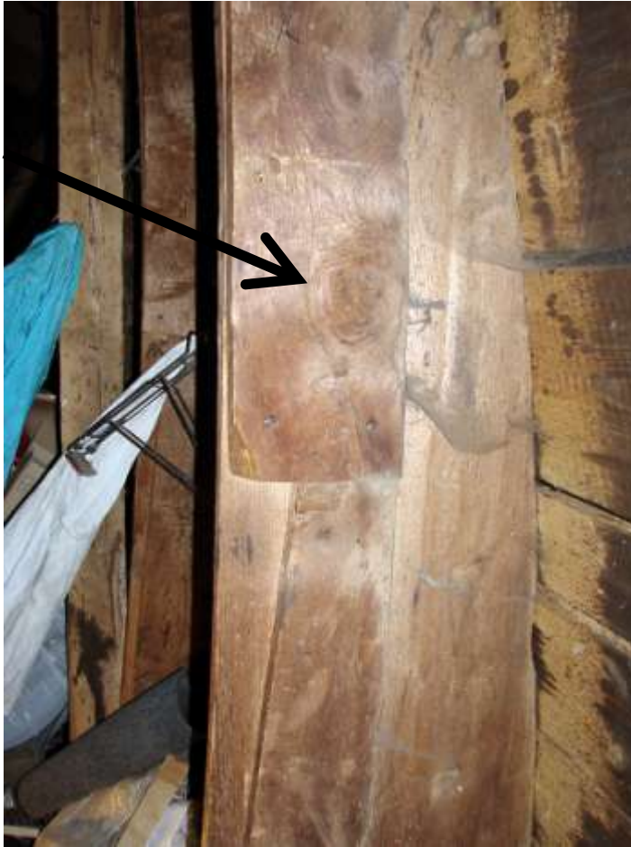
70. Bukowiec, Dom Ogrodnika, więźba, strona wschodnia, dolny fragment krążyny i przypustnicy, (fot. J. Modzelewska, 2008). Rewers krążyny pokazanej na il. 71. Widoczne pęknięcie deski wzdłuż słojów drewna.
