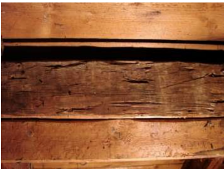
77. Bukowiec, Dom Ogrodnika, więźba, II kondygnacja, zachodnia płatew kalenicowa, widoczne ślady obróbki toporem (fot. J. Modzelewska, 2008).
