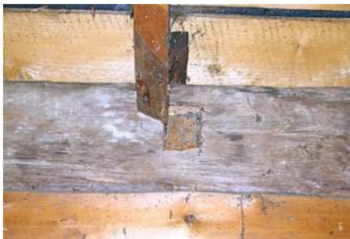
56. Bukowiec, Dom Ogrodnika, więźba, strefa kalenicy, detal połączenia czopowego krążyny z płatwią kalenicową, (fot. J. Modzelewska, 2008).
