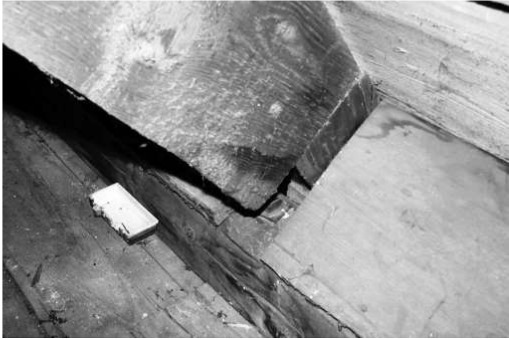
66. Bukowiec, Dom Ogrodnika, więźba, strona wschodnia, II kondygnacja poddasza. Widok skróconej krążyny i płatwi wprowadzonej w czasie przebudowy w latach 30-tych XX w., która prawdopodobnie połączona jest z belkami stropowymi za pomocą śrub, (fot. J. Modzelewska, 2008).
