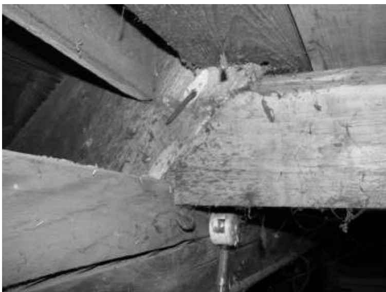
69. Bukowiec, Dom Ogrodnika, więźba, strona zachodnia, detal połączenia belki stropowej, płatwi i krążyny (detal nr 5), (fot. J. Modzelewska, 2008). Rysunek obok ilustruje sposób połączenia belki stropowej z krążyną.
