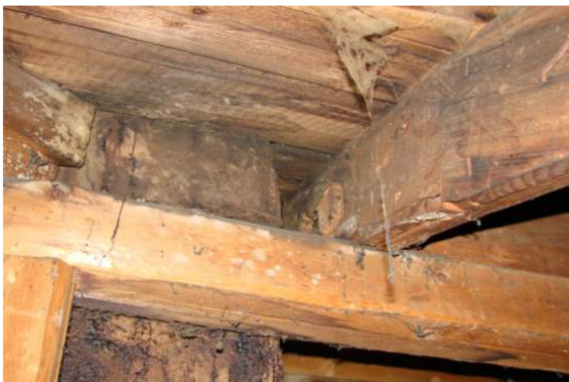
60. Bukowiec, Dom Ogrodnika, więźba, narożnik północno-zachodni, strefa kalenicy, fragment pokazujący połączenie na czop przelotowy skrajnej krążyny osi poprzecznej z płatwią; obok puste gniazdo po czopie przelotowym, (fot. J. Modzelewska, 2008).
