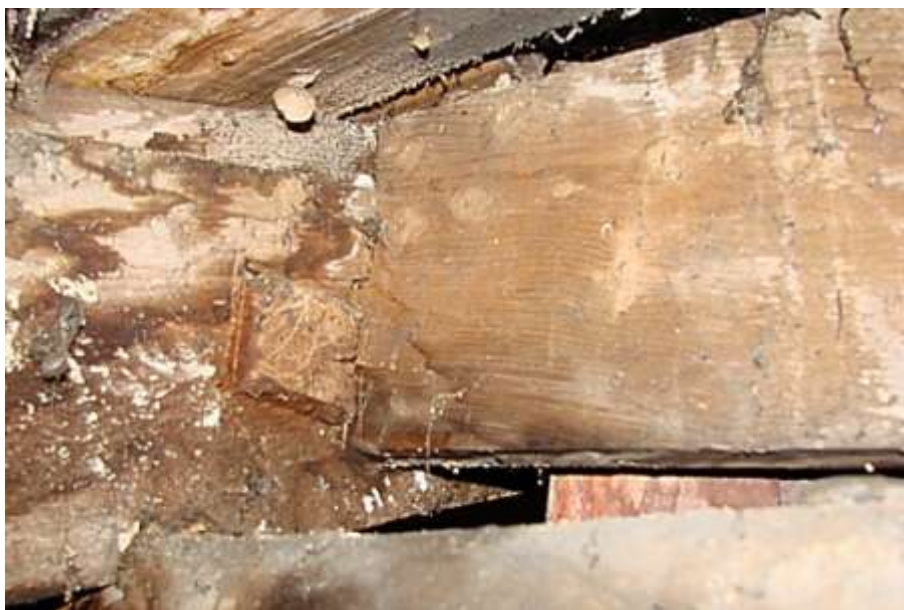
59. Bukowiec, Dom Ogrodnika, więźba, narożnik południowo-zachodni, strefa kalenicy, detal pokazujący połączenie na czop przelotowy skrajnej krążyny osi poprzecznej z płatwią i z krążyną osi podłużnej, (fot. J. Modzelewska, 2008).
