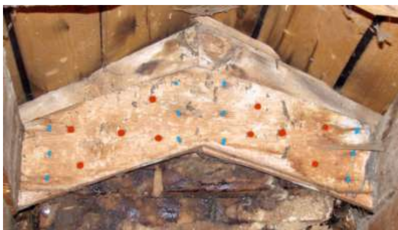
64. Bukowiec, Dom Ogrodnika, więźba, strefa kalenicy, skrajny wiązlar osi poprzecznej, widok na południową stronę węzła kalenicowego, którego połączenie na styk zakrywa przybita deska, (fot. J. Modzelewska, 2007).
