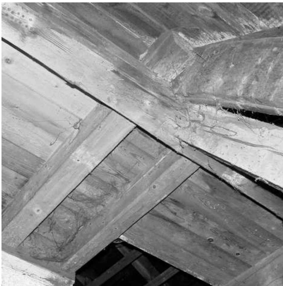
68. Bukowiec, Dom Ogrodnika, więźba, I kondygnacja, strona wschodnia, widok na belkę stropową, płatew podporowego systemu usztywniającego oraz na fragment krążyny, (fot. J. Modzelewska, 2008).
