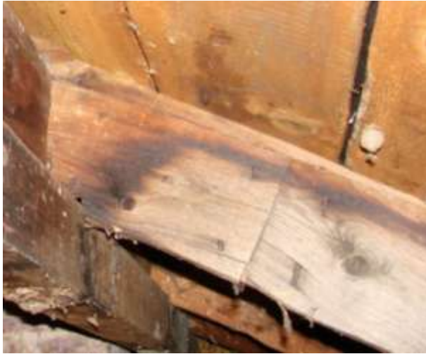
53. Bukowiec, Dom Ogrodnika, więźba, strefa kalenicy, wiązar środkowy osi poprzecznej, detal połączenia krążyny z płetwią kalenicową i oparcie jej na wtórnej płetwi za pomocą wrębu. Widoczny również schemat łączenia krążyn za pomocą żelaznych kutych gwoździ, (fot. J. Modzelewska, 2007).
