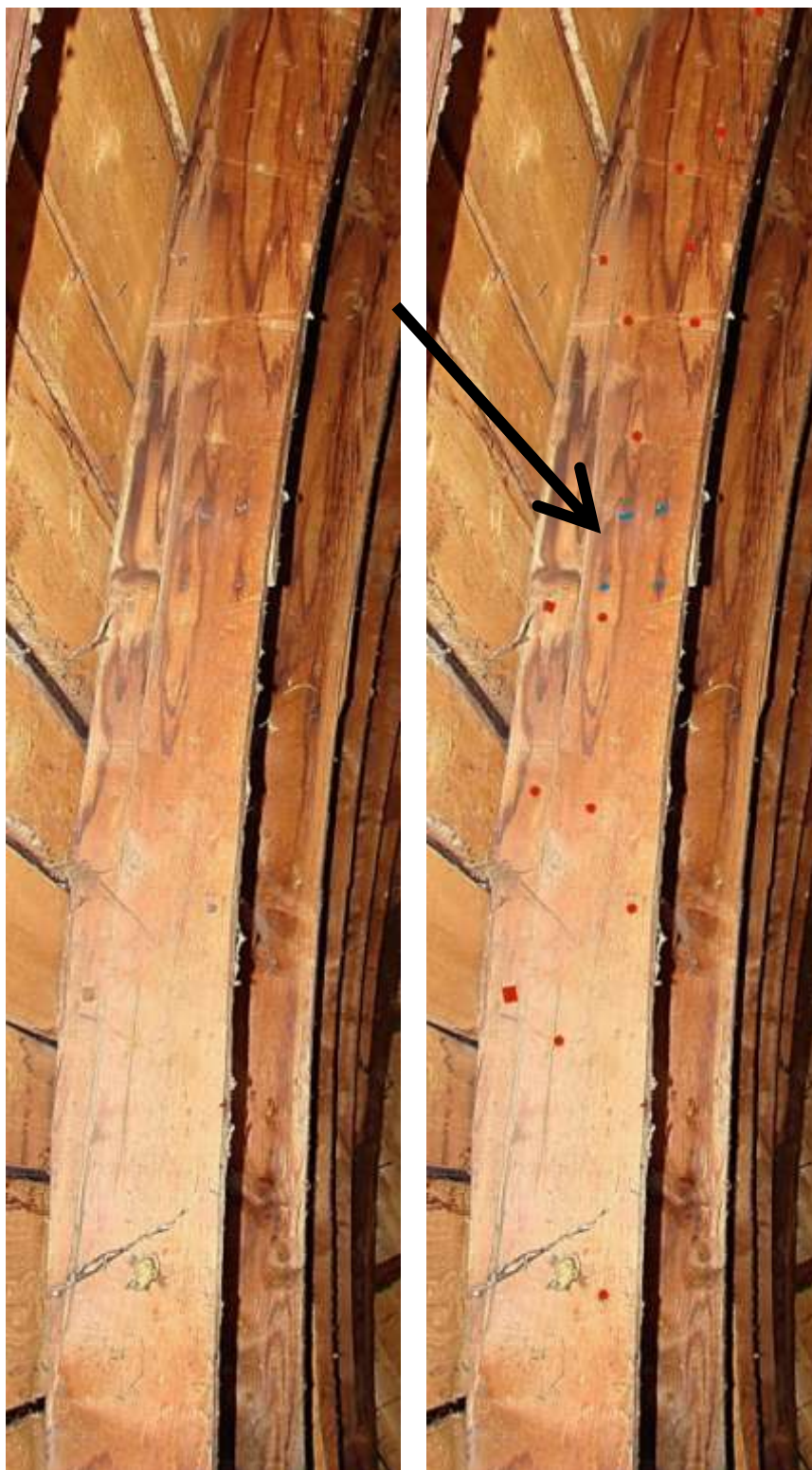
63. Bukowiec, Dom Ogrodnika, więźba, II kondygnacja, fragment zachodniej krążyny, sposób rozmieszczenia łączników budowlanych oraz ślady po narzędziu obcinającym kołki. Widoczny również sposób sztukowania krążyny – strzałka pokazuje granicę styku dwóch części desek, (J. Modzelewska, 2007).
