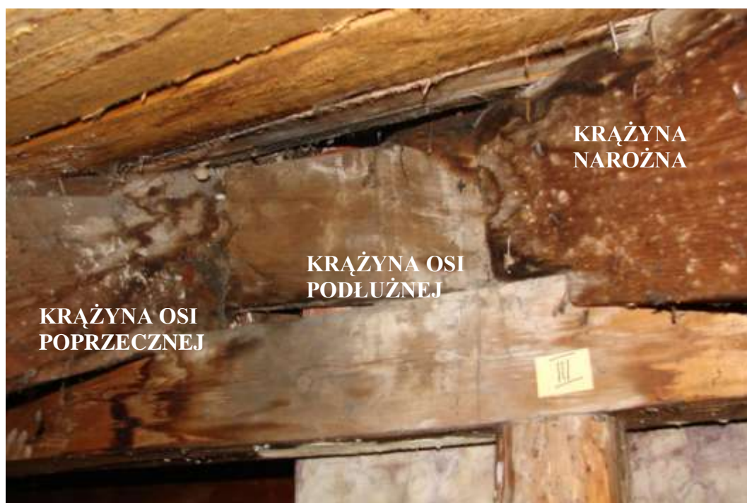
58. Bukowiec, Dom Ogrodnika, wieźba, narożnik południowo-zachodni, strefa kalenicy, fragment pokazujący połączenie na czop przelotowy skrajnej krażyny osi poprzecznej z płatwią i z krażyną osi podłużnej; z prawej strony krażyna narożna przybita do krażyny osi podłużnej i opartą na płatwi, (fot. J. Modzelewska, 2008).
