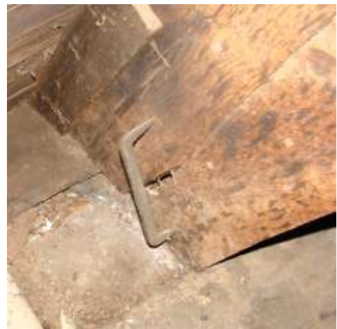
2. Bukowiec, Dom Ogrodnika, więźba, strona wschodnia, detal pokazujący oparcie krążyny na belce wiązarowej; widok od strony północnej (fot. J. Modzelewska, 2008).
