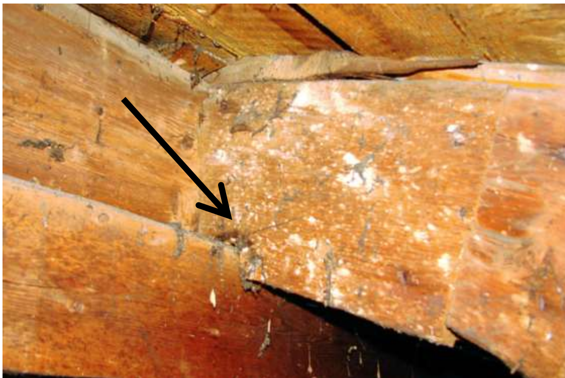
55. Bukowiec, Dom Ogrodnika, więźba, detal połączenia krążyny z płatwią kalenicową. Widoczne ślady narzędzia kreślarskiego wyznaczającego miejsce wycięcia wrębu w krążynie dla oparcia jej o wtórną płatew kalenicową, (fot. J. Modzelewska, 2008).
