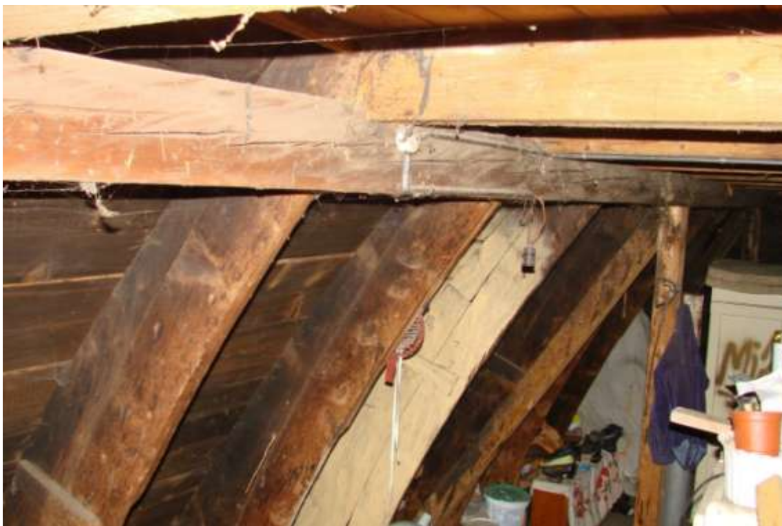
43. Bukowiec, Dom Ogrodnika, więźba, strona wschodnia, I kondygnacja poddasza z widokiem na dolną część środkowych krążyn osi poprzecznej oraz na podporowy układ konstrukcyjny, (fot. J. Modzelewska, 2008).
