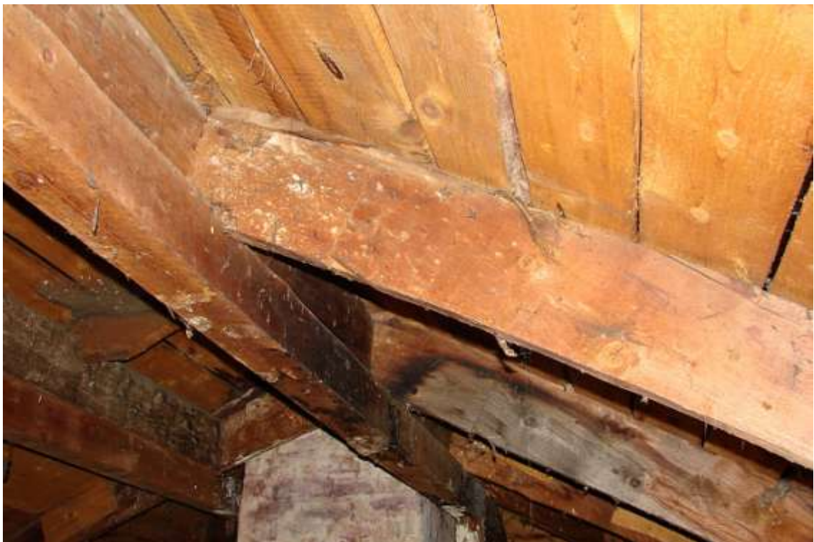
48. Bukowiec, Dom Ogrodnika, więźba, strefa kalenicy, widok od strony północnej na zachodnie krążyny i południowy komin, (fot. J. Modzelewska, 2008). Widać poważne zawilgocenie desek krążyn (w tle) i płatwi kalenicowych w postaci zaczernionych plam.
