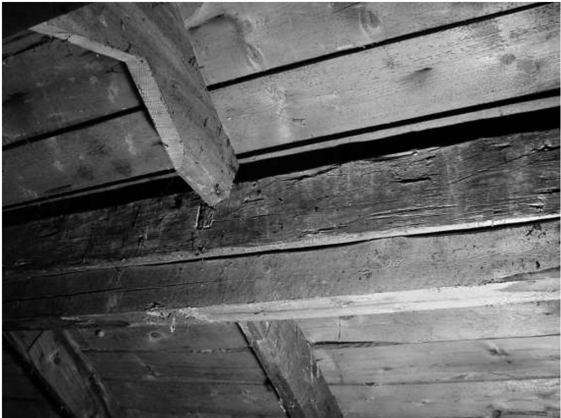
51. Bukowiec, Dom Ogrodnika, więźba, strefa kalenicy, zachodnia płatew kalenicowa w którą zaczopowane są krażyny, widoczne ślady obróbki toporem, (fot. J. Modzelewska, 2008).
