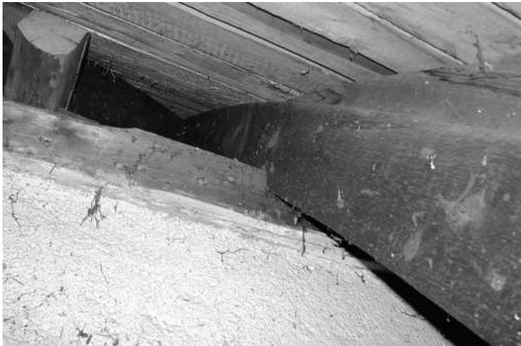
67. Bukowiec, Dom Ogrodnika, więźba, strona południowa, krążyna oparta na wrąg na belce stropowej konstrukcji mieszkania poddasza, (fot. J. Modzelewska, 2008).
