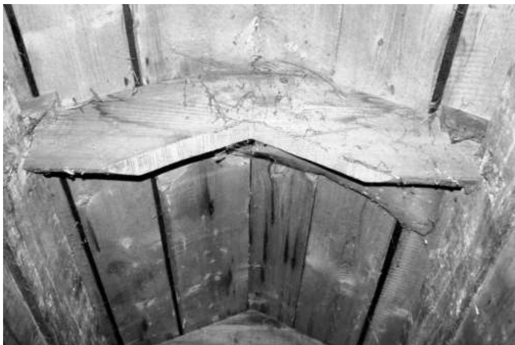
52. Bukowiec, Dom Ogrodnika, więźba, strefa kalenicy, widok na trójkątne elementy deskowe umieszczone pomiędzy płatwiami, (fot. J. Modzelewska, 2007).
