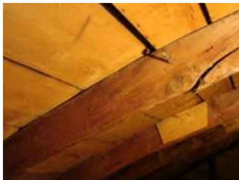
62. Bukowiec, więźba, strona wschodnia, II kondygnacja, fragment krążyny. Widoczne pęknięcie deski krążyny wzdłuż słoików drewna. (fot. J. Modzelewska, 2007).
