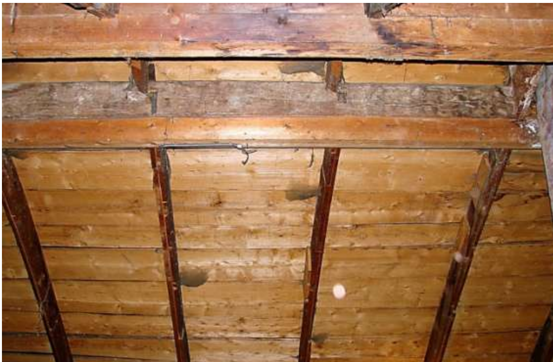
50. Bukowiec, Dom Ogrodnika, więźba, II kondygnacja, strona wschodnia, widok na środkowe krążyny oraz na pierwotną i wtórną płatew kalenicową, (fot. J. Modzelewska, 2008).
