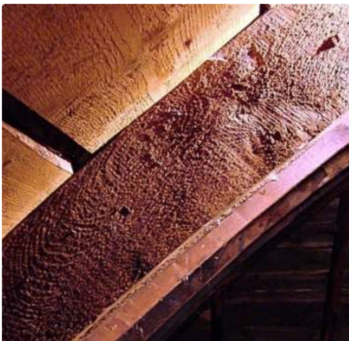
75. Bukowiec, Dom Ogrodnika, więźba, II kondygnacja, strona zachodnia, widoczne ślady obróbki bali krążyn piłą mechaniczną (fot. J. Modzelewska, 2008).
