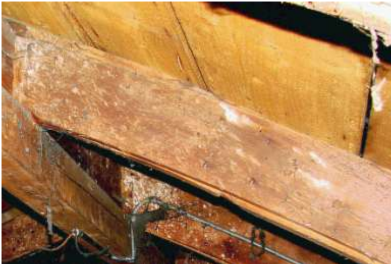
54. Bukowiec, Dom Ogrodnika, więźba, strefa kalenicy, wiązar środkowy osi poprzecznej, detal łączenia krążyn: dwie pary gwoździ przy styku desek i kilka kołków rozmieszczonych w polu desek, (fot. J. Modzelewska, 2007).
